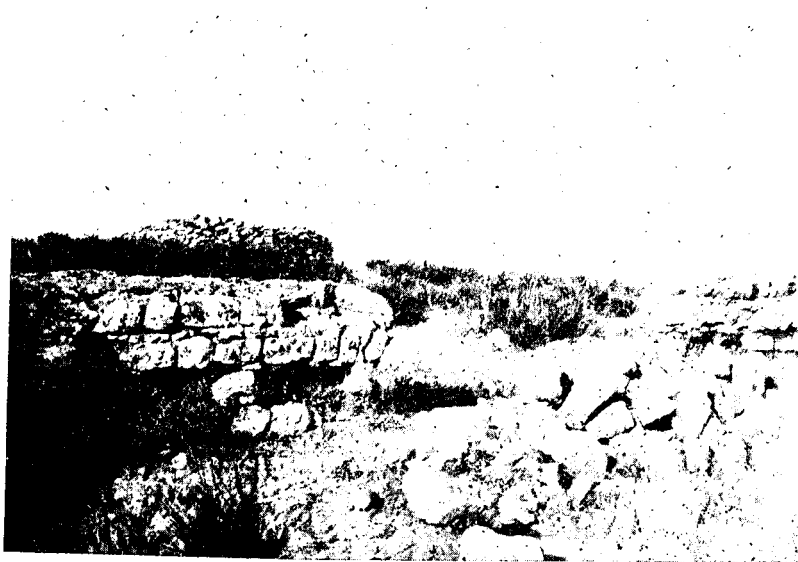
Fig. 4. — Poterne (?) en face du marabout.
