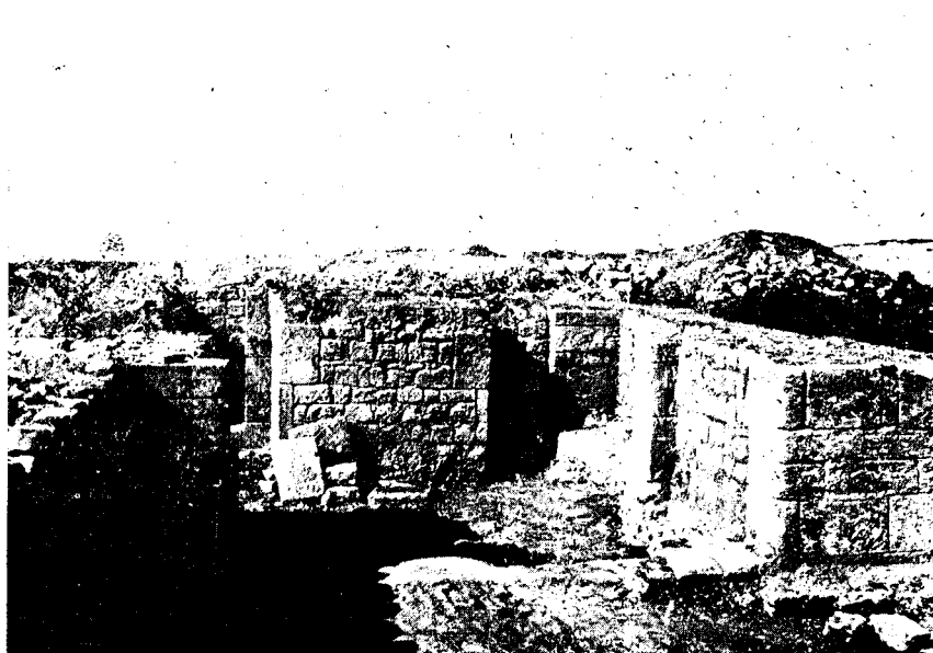
Fig. 7. — Porte de l'Ouest vue de l'intérieur
