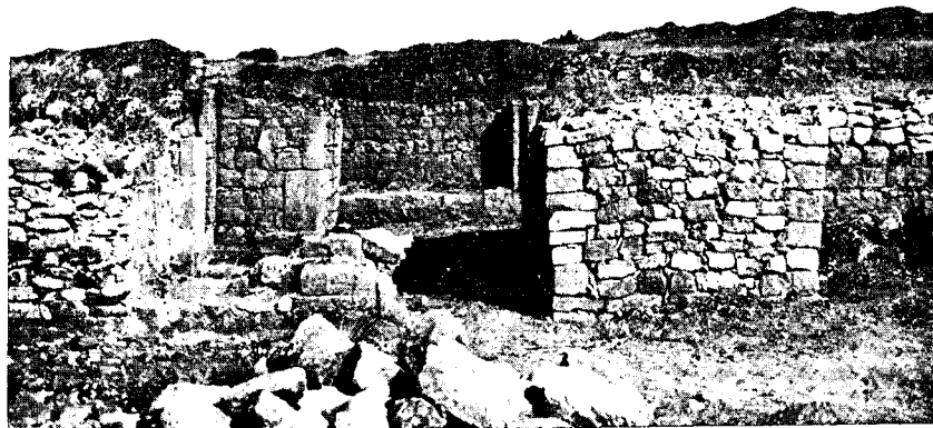
Fig. 6. — Porte de l'Ouest vue de l'extérieur.
